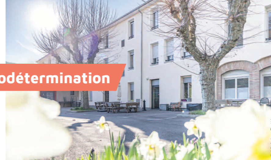
Foyer d'hébergement Grande Maison à Saint-Martin-le-Vinoux
