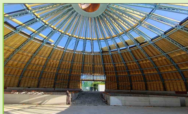
Les travaux sur l'ancienne piscine Tournesol se poursuivent avec la pose du revêtement qui formera le plafond du futur espace de glisses urbaines.
