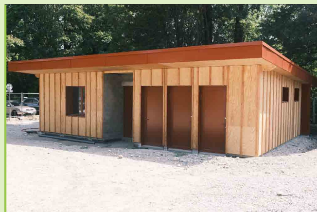
Le futur local de kayak prend forme avec la pose de la toiture du bâtiment.
