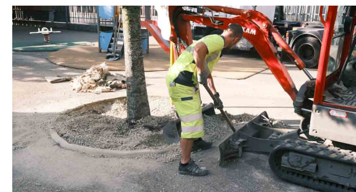
Les services techniques municipaux désimperméabilisent la cour de l'école maternelle Robert Badinter
