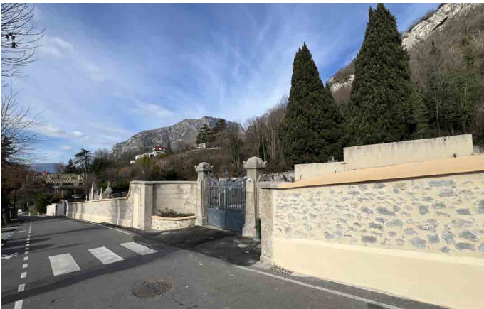
Le mur du cimetière entièrement rénové
