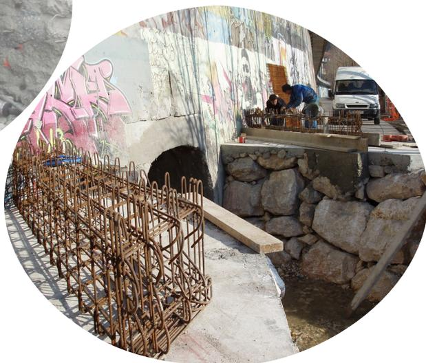
Des travaux de protection ont été réalisés par la ville dans le secteur des Chrysalides et sur toute la longueur du Souchet (850 000 €): un canal latéral de déviation permet de dévier l'excédent de crue du Souchet avant débordement.
